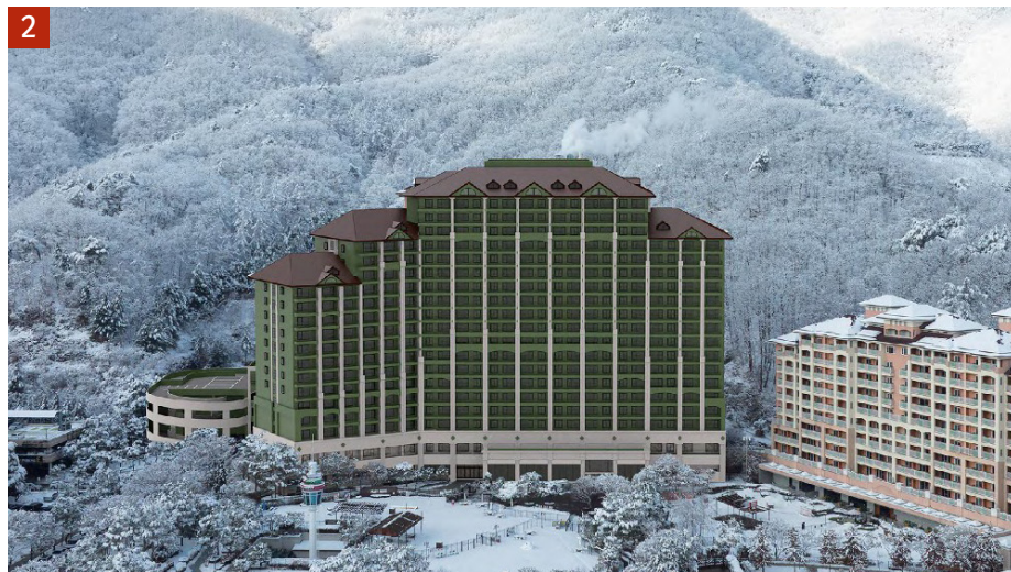
2 소노캄 비발디 D동 리뉴얼 공사 · 강원도 홍천군 서면 한치골길 262 · 리조트 366실 · 준공 2023년 12월
